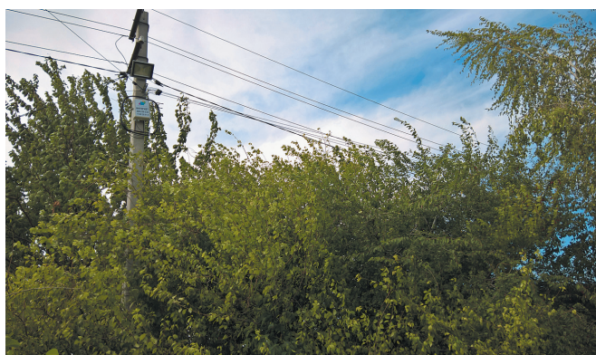
Рис.2. Пучки дроп-кабелей в ветвях деревьев
