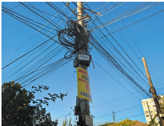
Рис.1. Сети FTTH в отсутствие требований к доступу на опоры ВЛ 0,4 кВ
